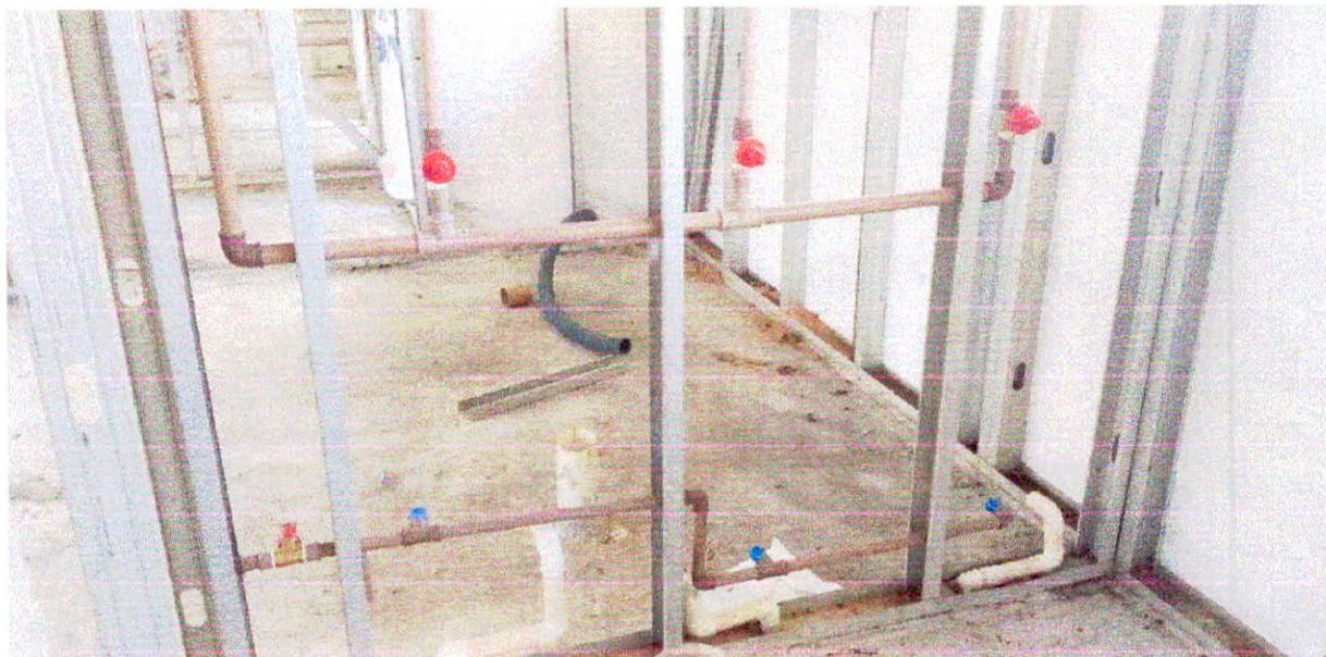
Fotografia 13 – Instalações de água fria com tubos e conexões executados. Fonte: Acervo Pessoal.
