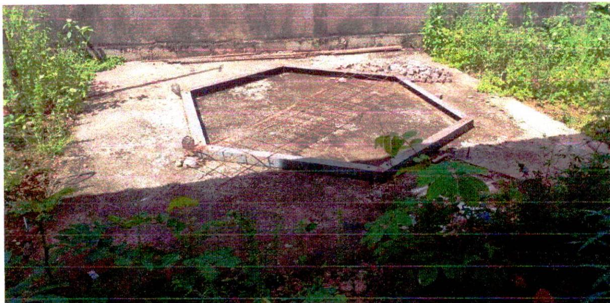
Fotografia 9 – Fundação do Reservatório concretada. Fonte: Acervo Pessoal.
