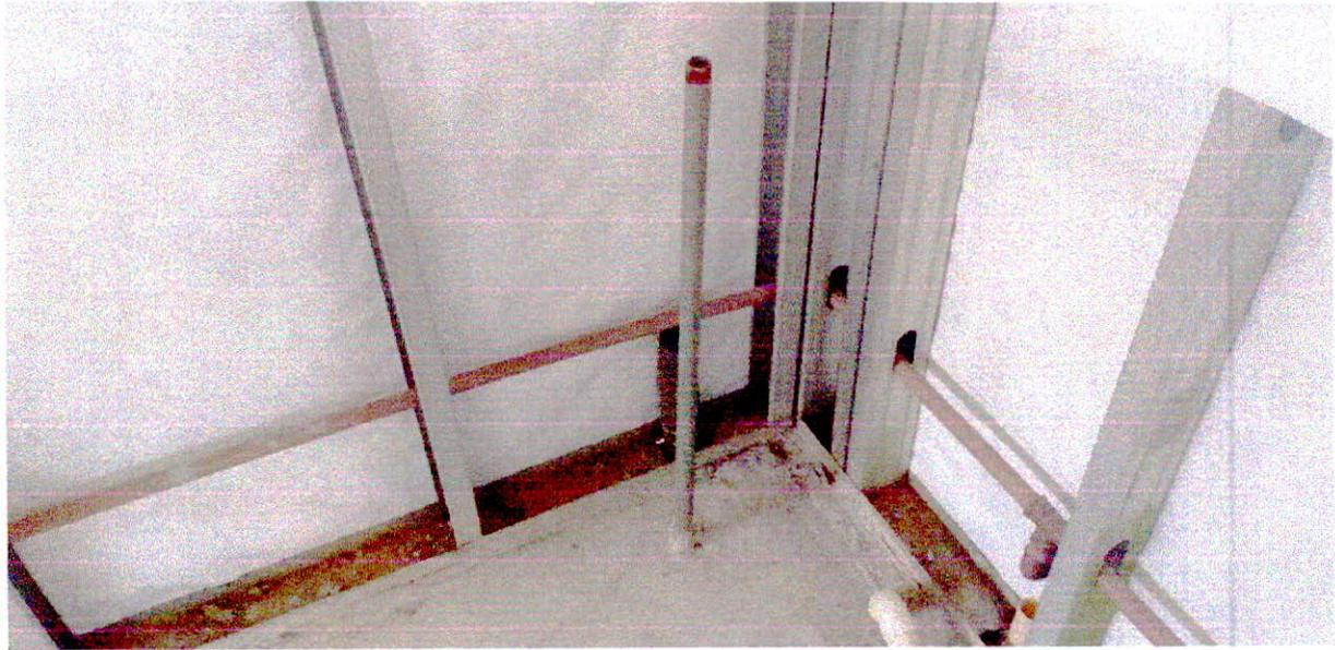
Fotografia 14 – Instalações de gás combustível com tubos e conexões executados. Fonte: Acervo Pessoal.
