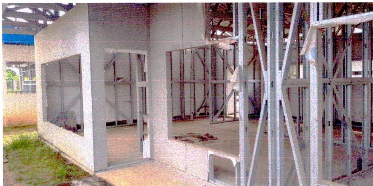
Fotografia 16 – Detalhe do local onde se paralisou o serviço de instalação de placas. Fonte: Acervo Pessoal.
