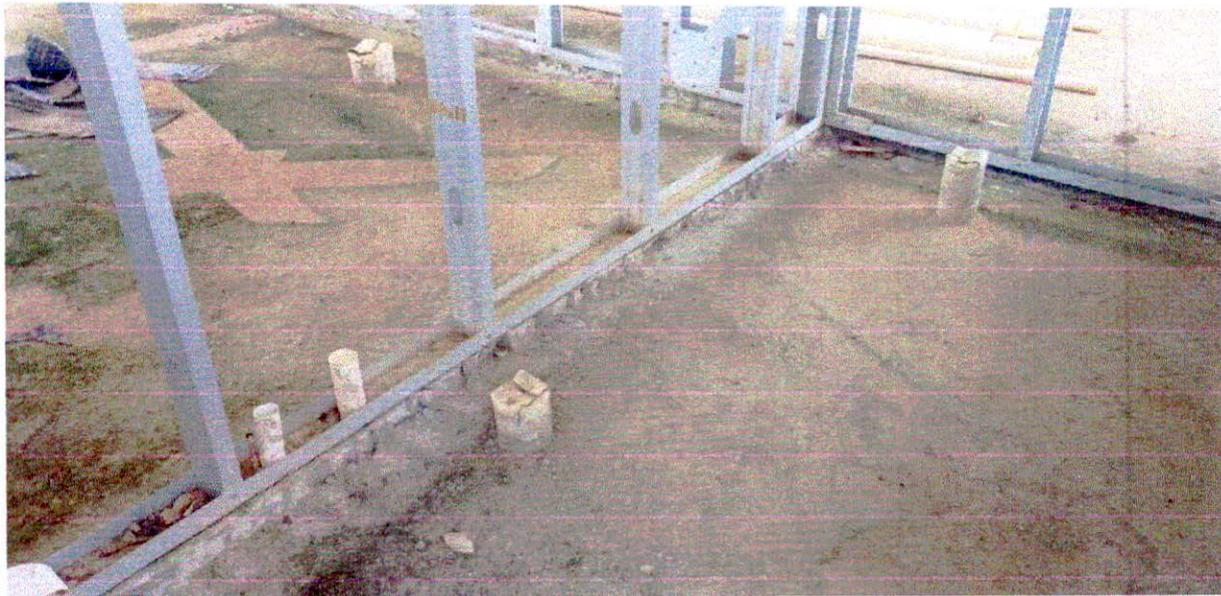
Fotografia 7 – Instalações de Água Fria não executadas. Fonte: Acervo Pessoal.
