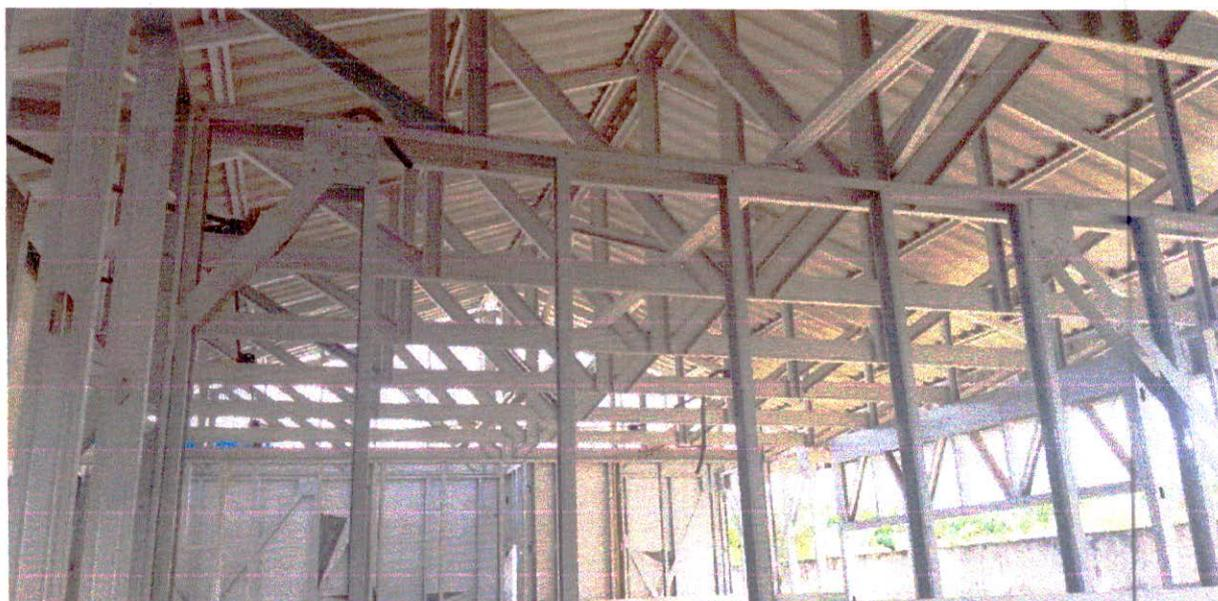
Fotografia 18 – Tesouras do Bloco Multiuso fabricadas e montadas. Fonte: Acervo Pessoal.
